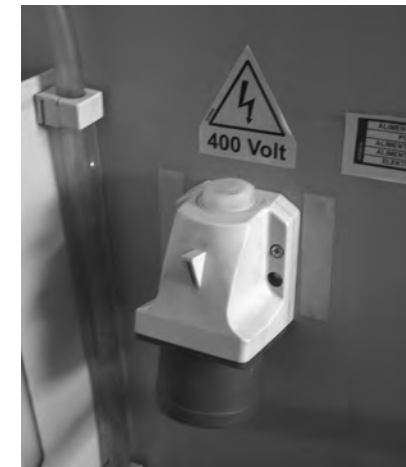
Fig 1 : 415 volt Appliance inlet plug
