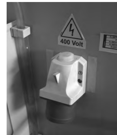
Fig 1 : 415 volt Appliance inlet plug
